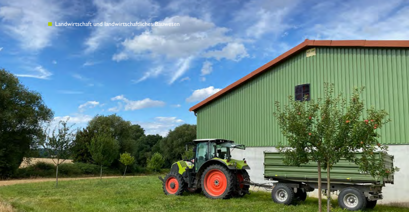
Neubau einer Mehrzweckhalle in Fuldabrück-Dennhausen, Landkreis Kassel
