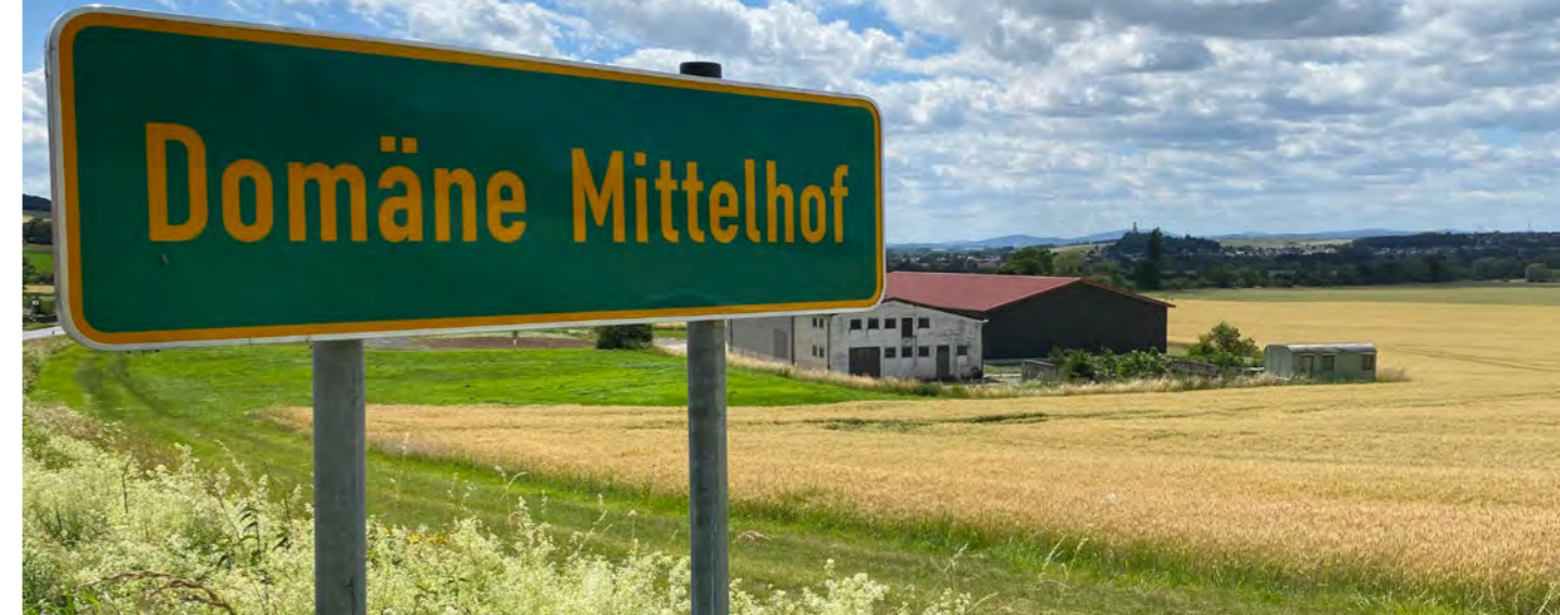
Beide Abb.: Staatsdomäne Mittelhof mit Herrenhaus und Wirtschaftsgebäuden bei Gensungen, Schwalm-Eder-Kreis
