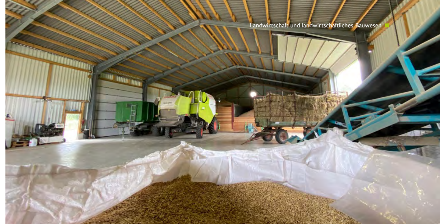
Innenansicht der Mehrzweckhalle in Fuldabrück-Dennhausen, Landkreis Kassel
