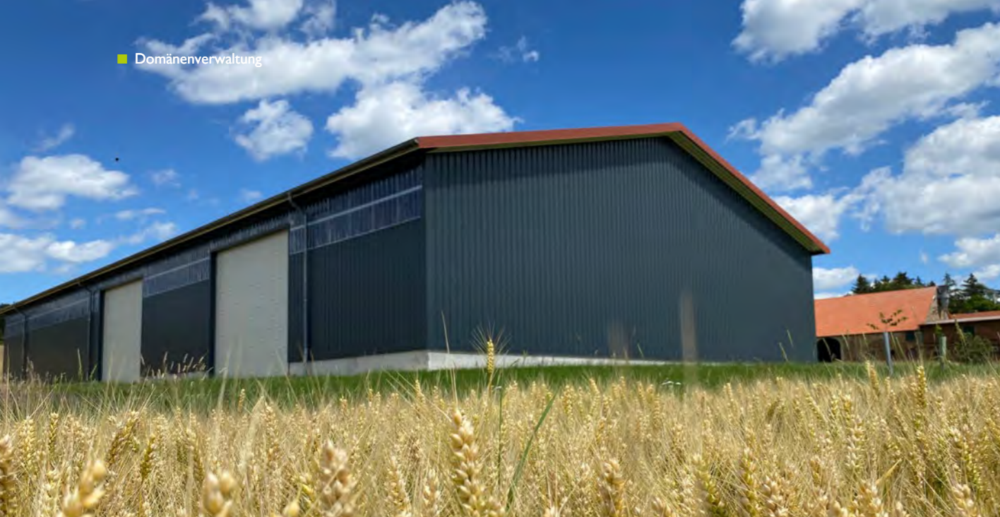
Neue Mehrzweckhalle auf der Staatsdomäne Mittelhof, Schwalm-Eder-Kreis
